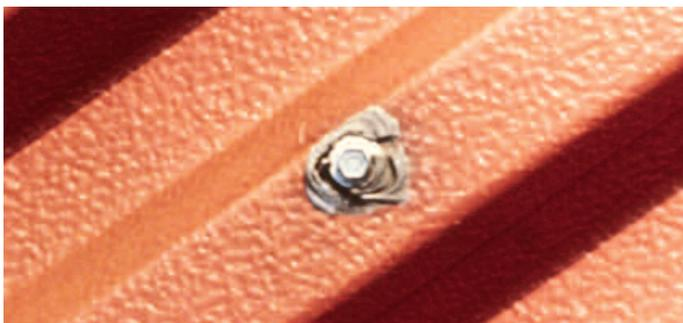
Поврежденный крепежный элемент кровли.
